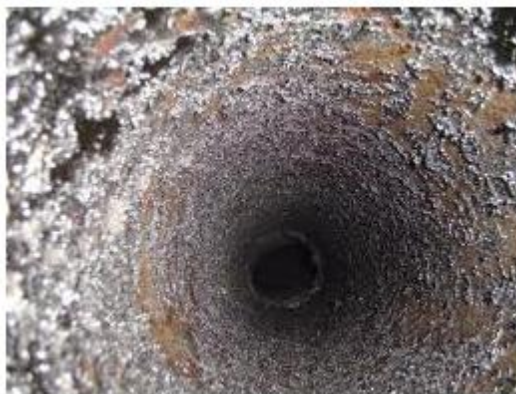
Conduit avant ramonage
