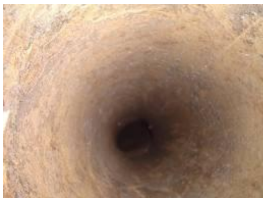
Conduit après ramonage
