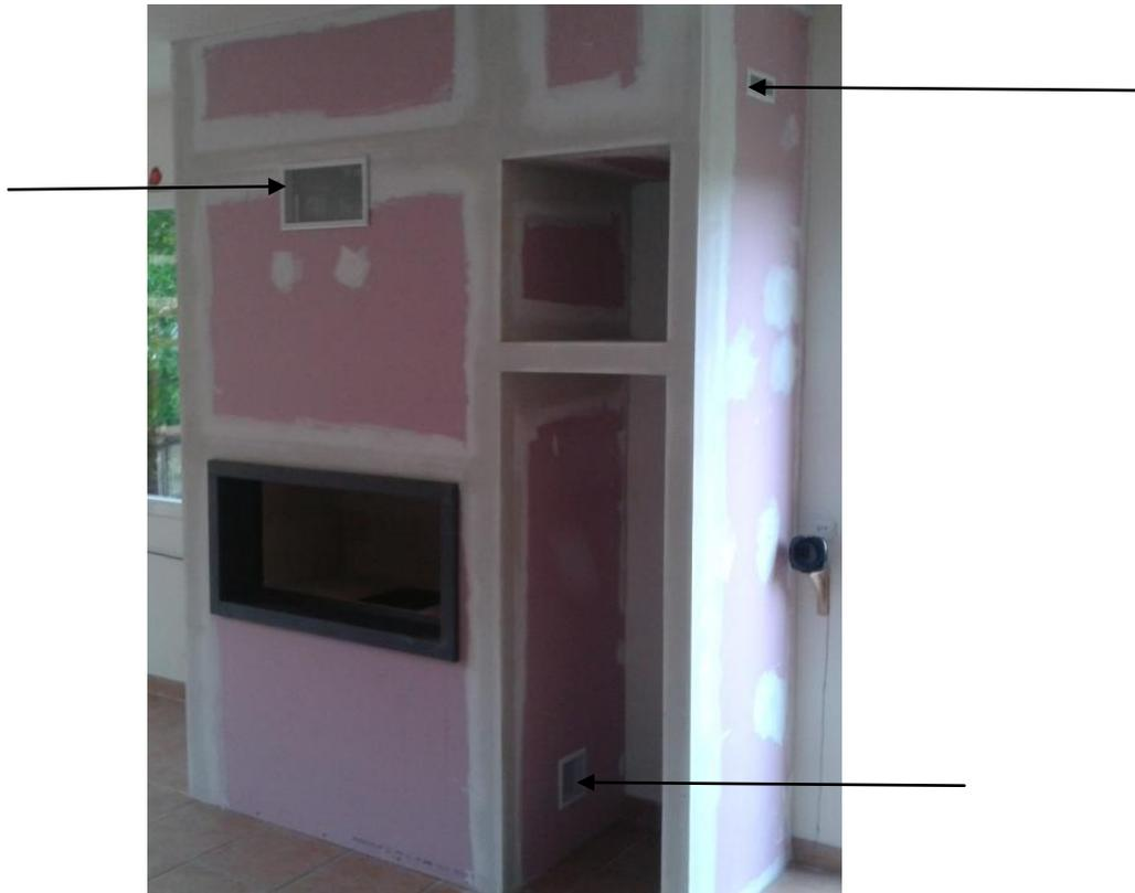
Nettoyer l'intérieur de l'installation à l'aide d'un aspirateur ou balai afin d'éliminer tout dépôt de poussières générateur de phénomène de carbonisation des poussières (salissures au pourtour des bouches de diffusion d'air chaud) en début de la saison de chauffage et une fois durant la période de chauffe.
