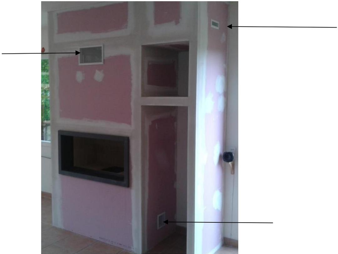
Nettoyer l'intérieur de l'installation à l'aide d'un aspirateur ou balai afin d'éliminer tout dépôt de poussières générateur de phénomène de carbonisation des poussières (salissures au pourtour des bouches de diffusion d'air chaud et au plafond) en début de la saison de chauffage et une fois durant la période de chauffe.
