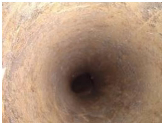
Conduit après ramonage
