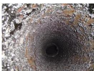
Conduit avant ramonage
