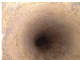
Conduit après ramonage
