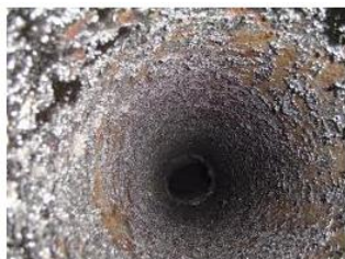
Conduit avant ramonage
