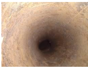
Conduit après ramonage
